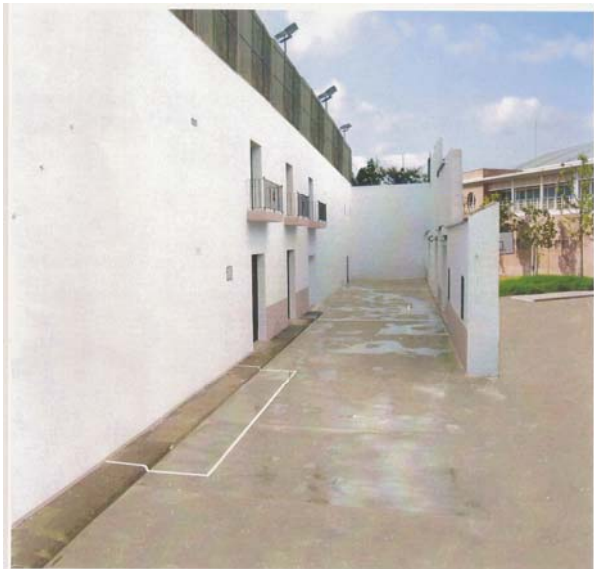
Actualment estem treballant en la construcció d'un carrer artificial per a pilota valenciana i d'una piscina descoberta.
