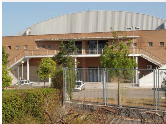
Detall del Pavelló, en procés de Reparació i millora.
